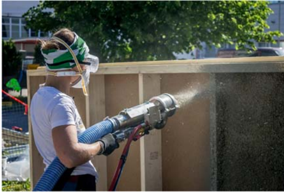
Noora Norokytö opettelee ruiskuttamista koeseinään.
